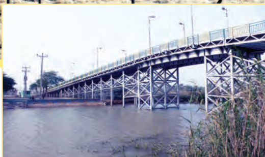
◆ پل ارتباطی جزیره مینو و آبادان
