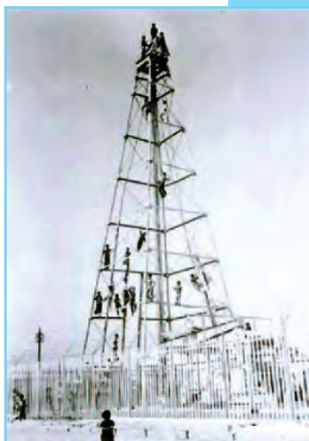
◆ عکس تاریخی چاه شماره یک
